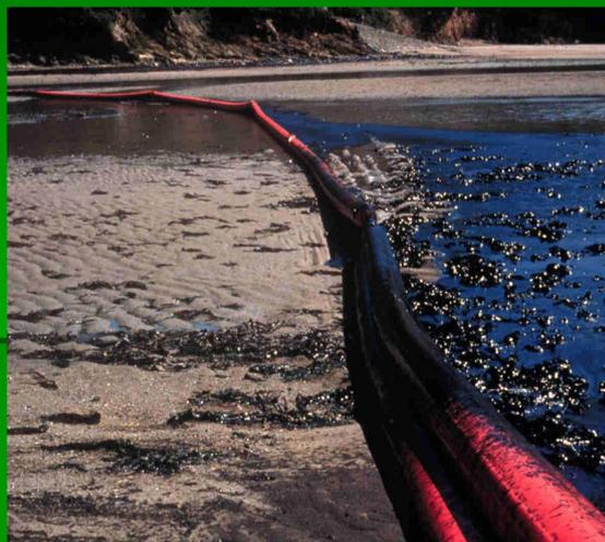
图7 岸线围油栏的布控
