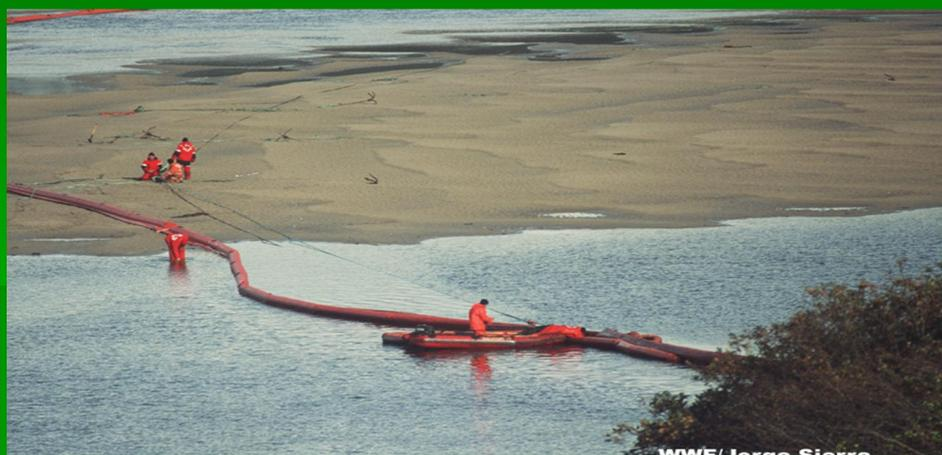
图8 岸线围油栏的布控
