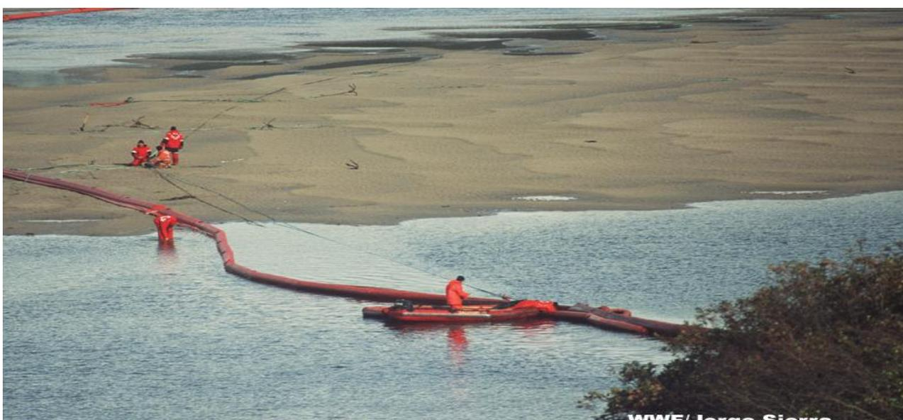
图 19 岸滩围油栏的布放方式二
